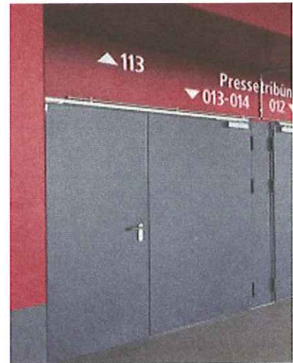
BrS-Tor EI 30 mit Servicetüre Ansteuerung
