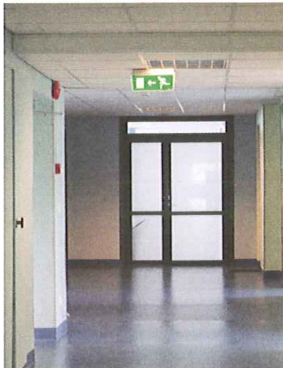
BrS-Türe E 30 ohne Dämmung Glas: Ätz-Stempel
