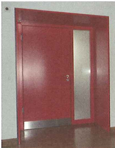
BrS-Türe EI 30 mit Dämmung
