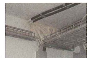
Kabelschott
